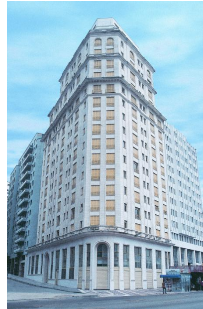
RISKALLAH JORGE, 50 15 andares 167 unidades concluído em fev/2002 Projeto de Reforma: Helena Saia Iniciativa: UMM
